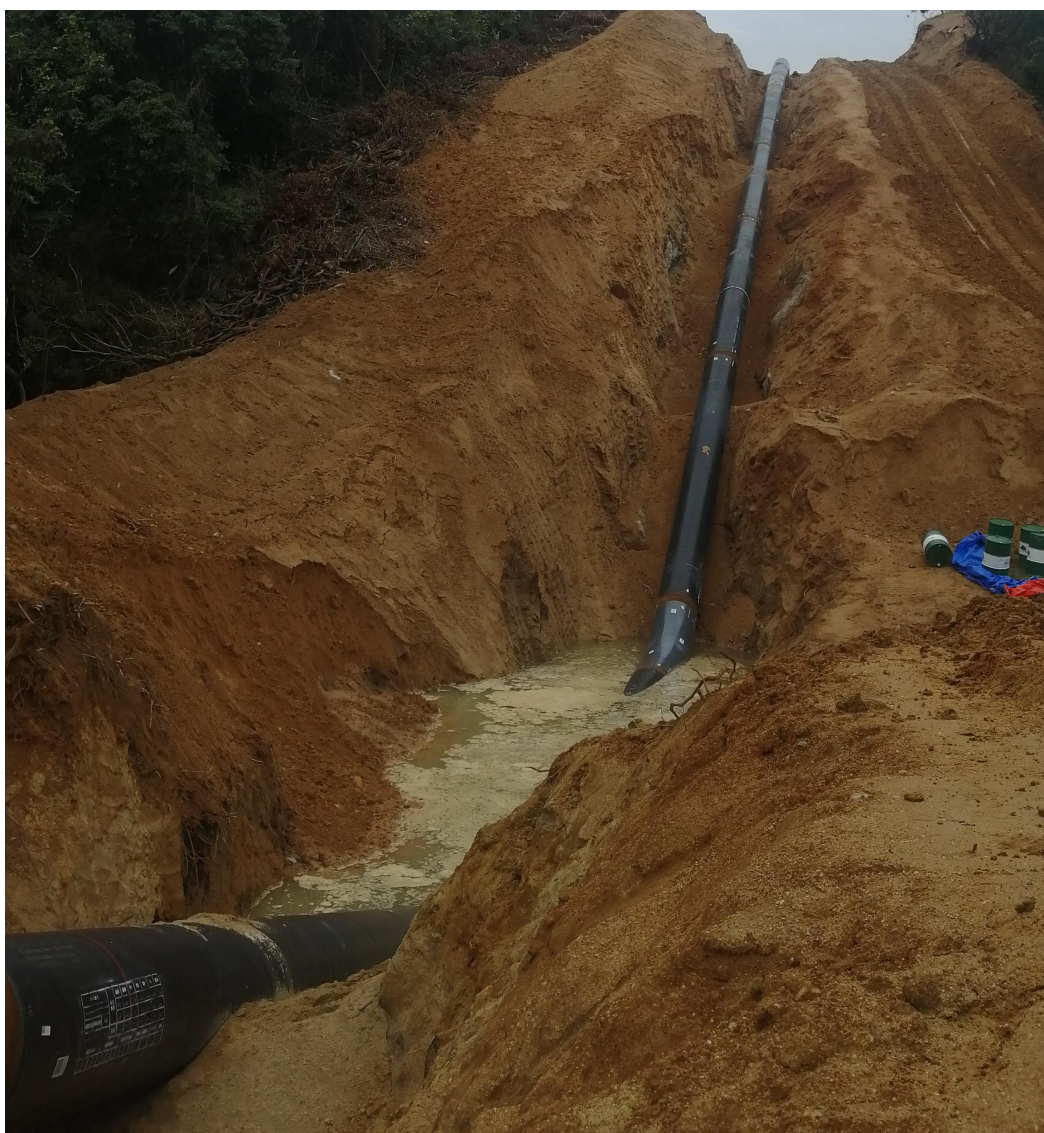
1016 管线 6D 弯管施工现场
