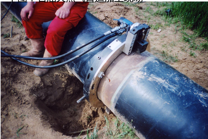
下图：石油天然气管道加工现场
